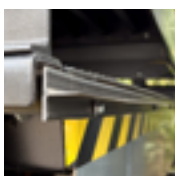
JUNTA DE ESTANQUEIDAD DE RAMPA
