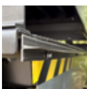
JUNTA DE ESTANQUEIDAD DE RAMPA
